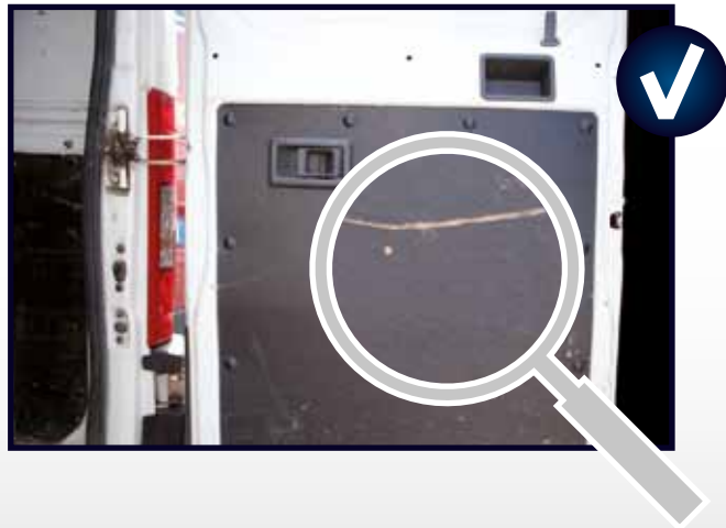
NORMALE USURA: pannello rivestimento porta carico in buono stato.
